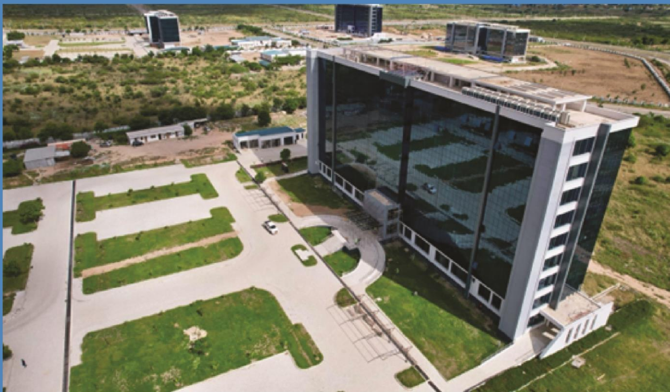
Muonekano wa Jengo la utawala la Ofisi za Wizara ya Afya lililopo Mtumba Jijini Dodoma ambalo kwa sasa ujenzi wake umefikia asilimia 92.
